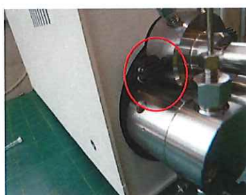
ポンプ吐出ポート左側吐出確認
