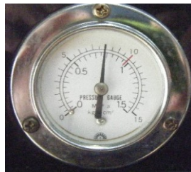
圧力約0.8MPsにて再稼働
