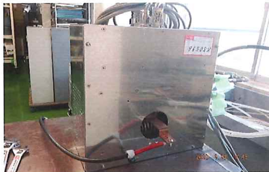
マッチングボックス 配線、配管後 動作確認
