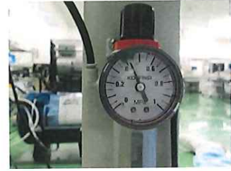
除振台圧力(0.4MPa)供給確認
