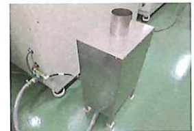
排気サイレンサー取り付け
