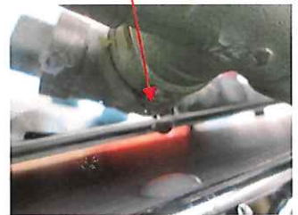
排水コックより漏水 15秒に一回滴下
