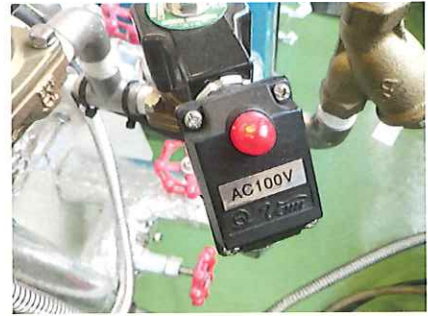
冷却水電磁弁AC100V
