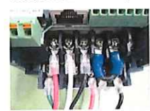
P1-P(+)-短絡ケーブル取り付け
