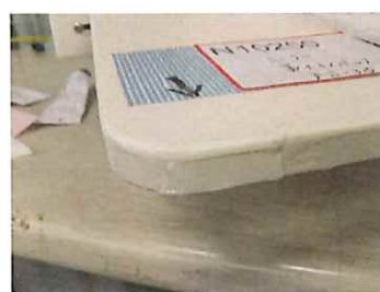
一部プラ破損補修
