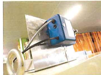
電動ダンパー交換済み。
