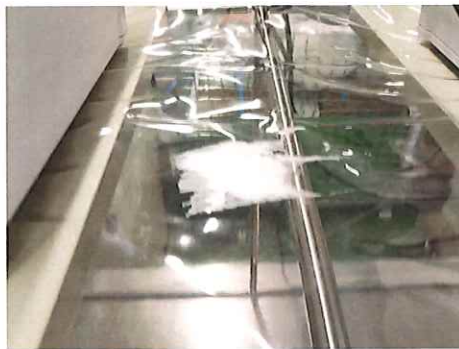
ビニール補修。
