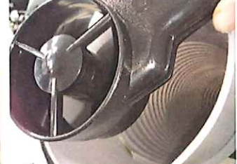
内径φ144mmダクトで風速測定
