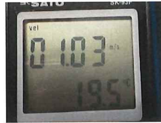
吹出風速測定
