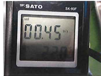
吹出風速測定
