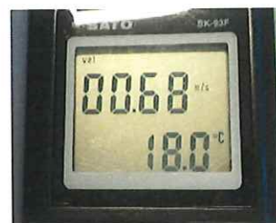
吹出風速測定
