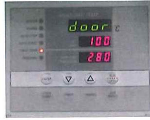
稼働中の扉開け
