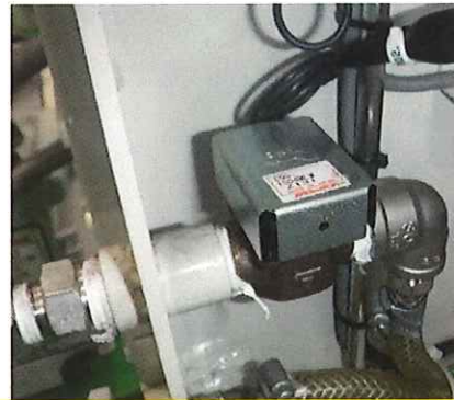
フロースイッチ:CQS-1504MLW (鷺宮製作所)
