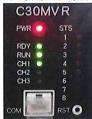
CH1冷却起動
